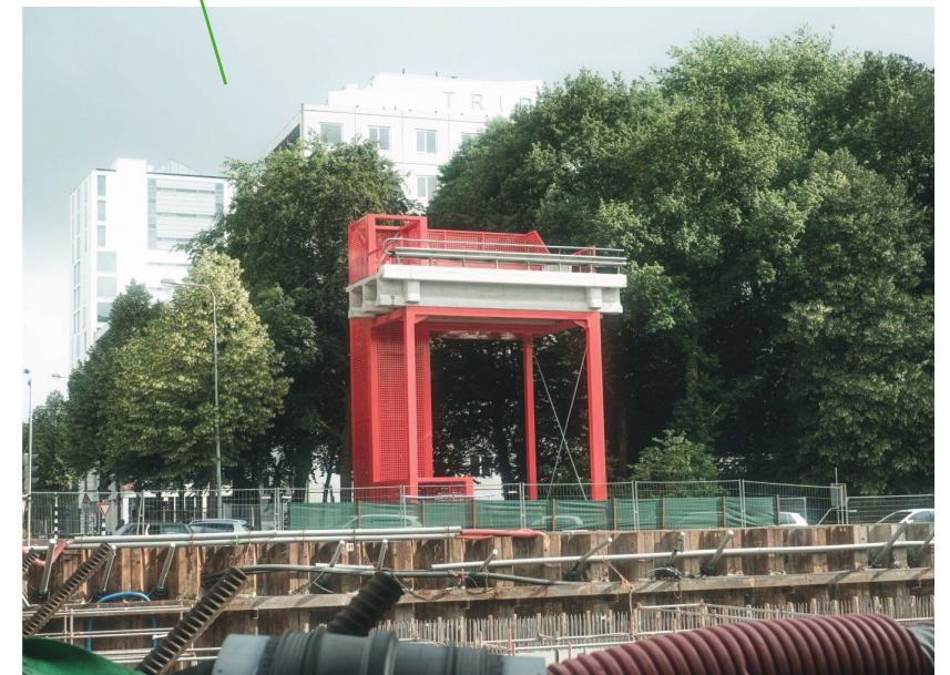
Geheugenbalkon langs Hereweg met zicht op werkzaamheden Combinatie Herepoort
