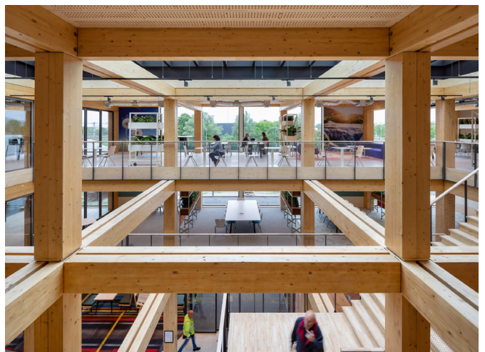
Flexibel indeelbaar, duurzame houten constructie (Alliander Amsterdam)
