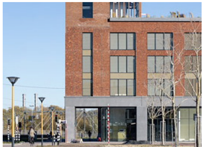
Parkeergebouw staat stevig op de grond (Zecc Architecten)
