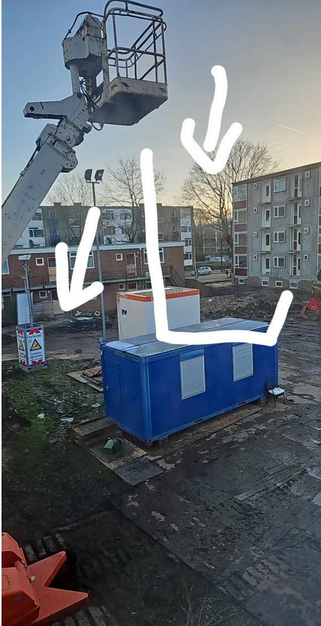
Foto waarin duidelijk wordt waar ze langs hadden gekund met de graafmachines voor de bouwwerkzaamheden
