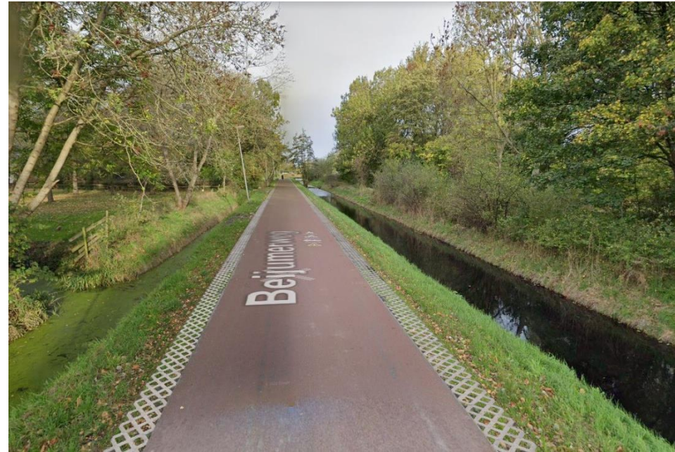
Variant met grasbetonstrook
